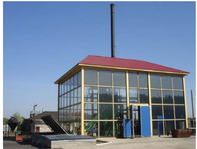
Рис. 2. Общий вид промышленной установки с топливным складом
